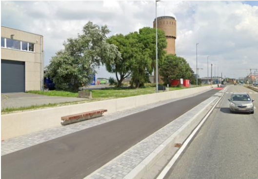
Kustlaan t.h.v. watertoren; recente fiets- en voetpaden gescheiden van de rijweg
